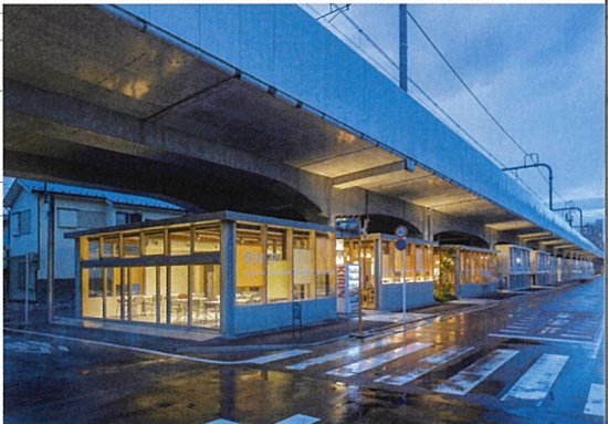
食堂からL棟方向を見る。中央ラインハウス全体の照明が高架のスラブ面を間接的に照らすことで、通りを明るくする。
