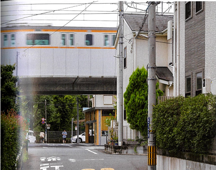
上：食堂より北側接道を見る。木製サッシのマリオンは、60×160のベイヒ集成材。 下：敷地を南北に貫く通りよりホールを見る。
