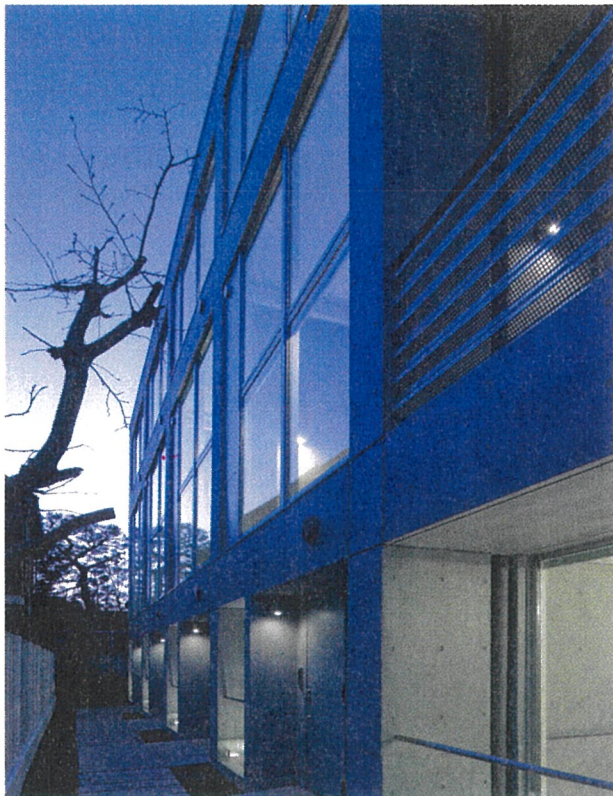
南側外観。ほとんどがガラスの開口部。
